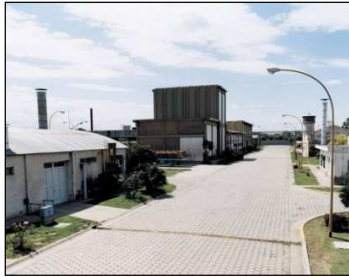
Vista general de Dioxitek SA
